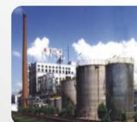
浙江赐富化纤 500RT、700RT、1000RT 约20台
