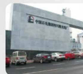
中石化四川维尼纶厂 1320RT、1650RT 7台
