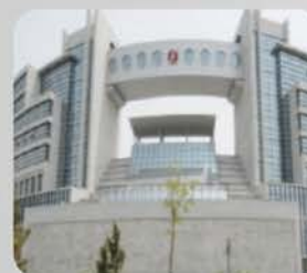
天津高新纺织集团 800RT、1200RT、1400RT 14台
